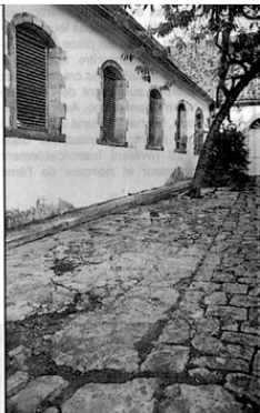
Toute une atmosphère particulière, aux abords de l'église du Marin.
